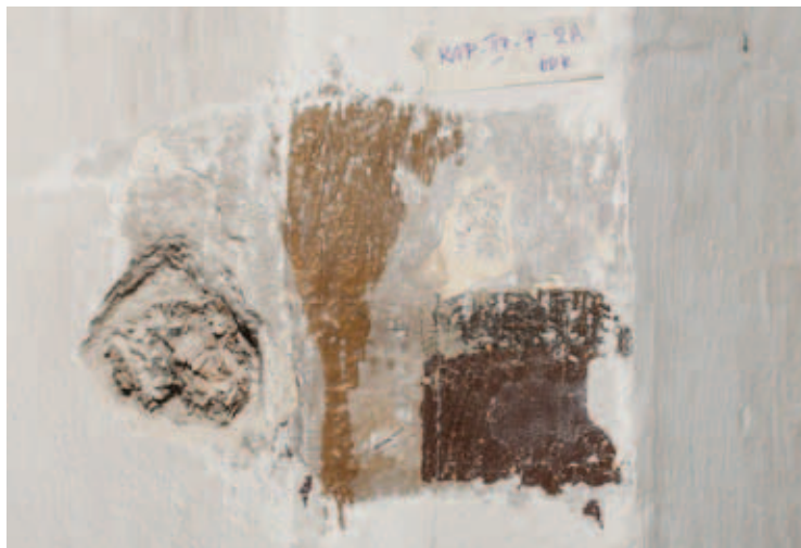
odkrywka KAP-IV-ZACH_2W- ściana zachodnia
