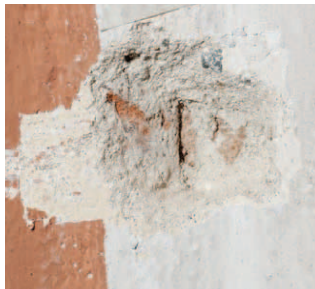
odkrywka N-I-L_10S- wysklepek i żebro
