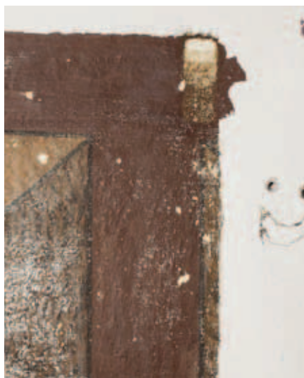
odkrywka KAP-IV-ZACH_1W- ściana zachodnia
