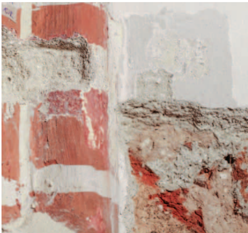
odkrywka KAP-III-L_1W- ściana północna 1 czerwony 2 czerwony 3 tynk szary, wapienny z dodatkiem cementu 4 tynk jasnoróżowy
