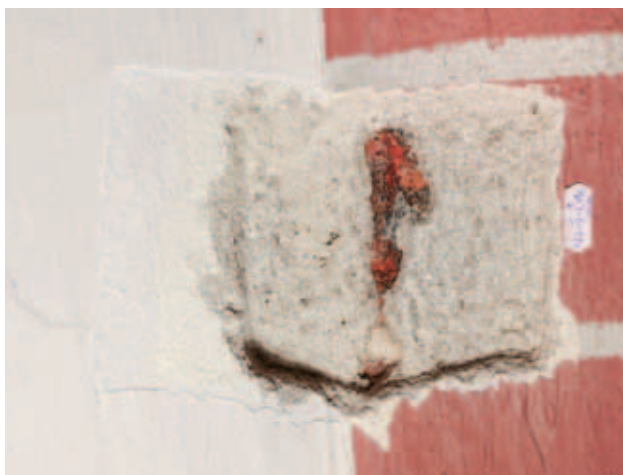
odkrywka NG-II-L_1S- wysklepek i żebro
