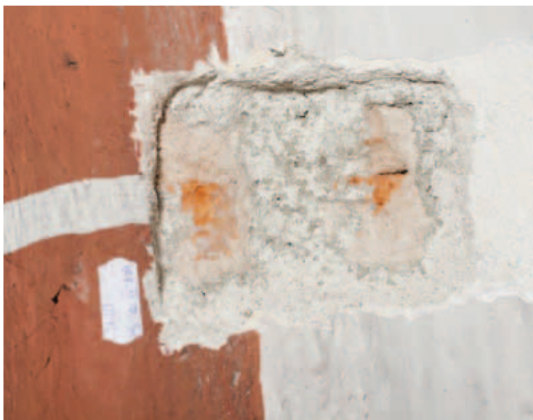
odkrywka KAP-III-P_5S- wysklepek i żebro 1 biała 2 szarobłękitna 3 kremowa 4 tynk szary, wapienny z dodatkiem cementu 5 tynk jasnoróżowy 6 cegła
