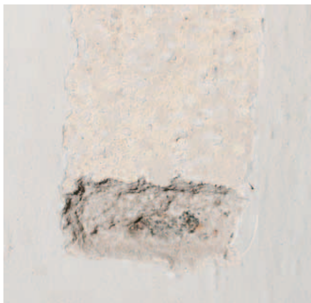
odkrywka N-I-L_6W- ściana północna 1 biała 2 błękitna 3 kremowa 4 tynk szary, wapienny z dodatkiem cementu 5 zabrudzenie 6 cegła
