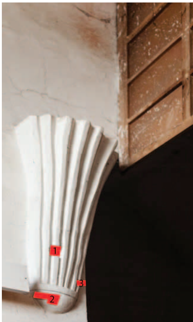
odkrywka CH-III-L_2W- cokół konsoli północnej 1 biała 2 kremowa 4 tynk szary, wapienny z dodatkiem cementu 5 tynk jasnoróżowy 6 cegła
