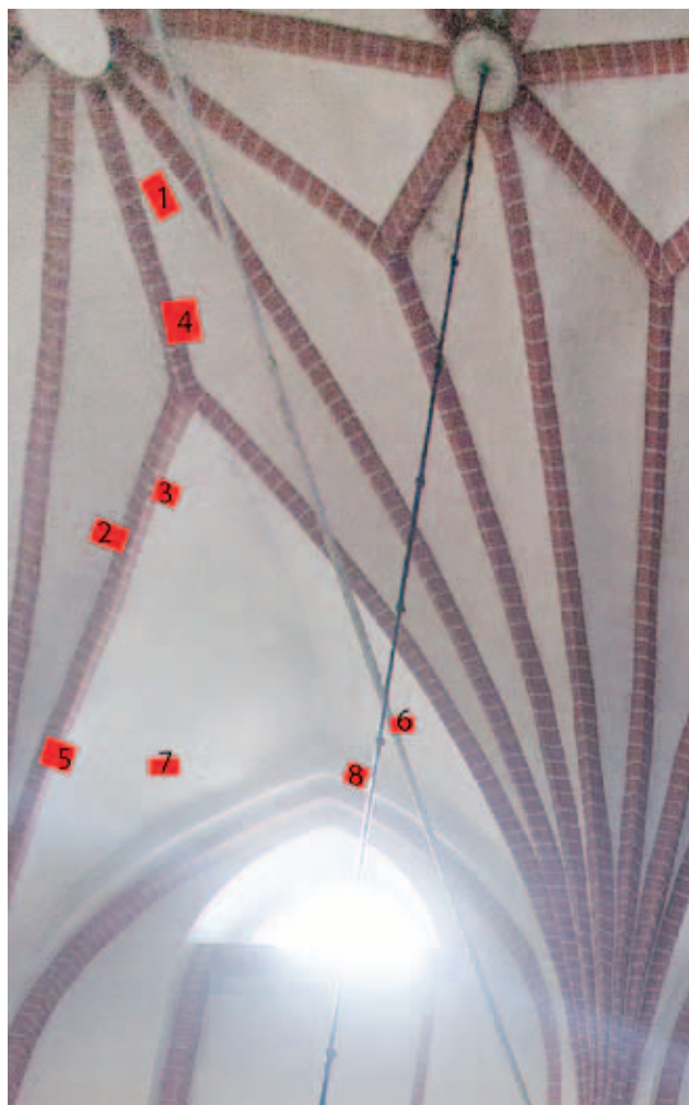
odkrywka NG-I-P_2S- wysklepek i żebro
