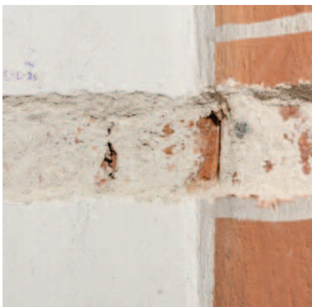
odkrywka N-I-L_8S- wysklepek i żebro
