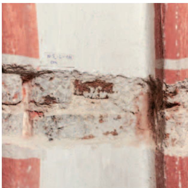
odkrywka N-II-L_1W- ściana północna 1 biała 2 błękitna 3 tynk szary, wapienny z dodatkiem cementu 4 tynk jasnoróżowy 5 cegła
