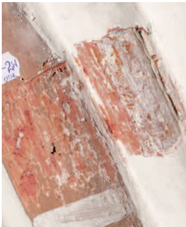
odkrywka P-III-P-2W- opaska blendy południowej 1 biała/czerwona 2 szara 3 czerwona
