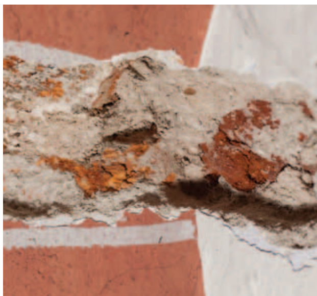
odkrywka NG-III-P_8S- wysklepek i żebro 1 biała 2 błękitna 4 tynk szary, wapienny z dodatkiem cementu 5 tynk jasnoróżowy 6 cegła
