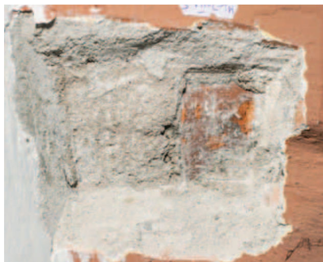
odkrywka S-VII-L_1W- ściana północna, konsola
