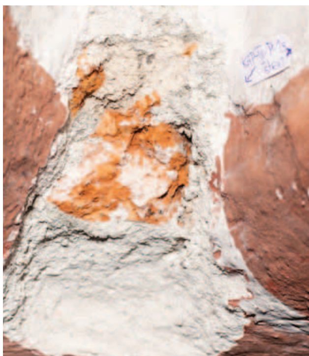
odkrywka KAP-III-P_4S- zwornik 1 biała 2 szarobłękitna 3 tynk szary, wapienny z dodatkiem cementu 4 tynk jasnoróżowy 5 cegła
