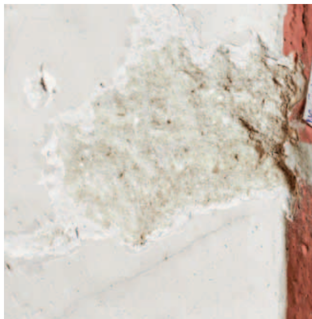
odkrywka NG-I-L_3S-wysklepek, spływ do konsoli 1 biała 2 błękitna 3 kremowa 4 tynk szary, wapienny z dodatkiem cementu
