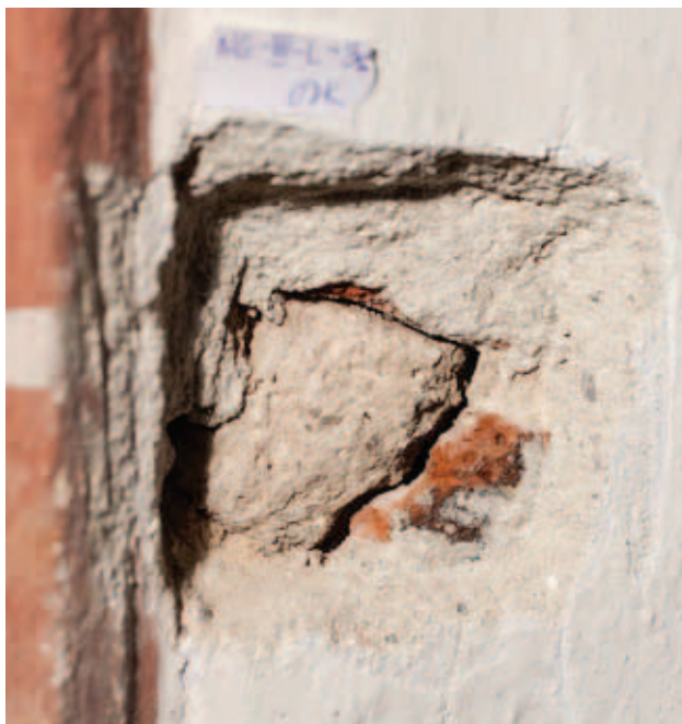
odkrywka NG-III-L_45- wysklepek 1 biała 2 błękitna 4 tynk szary, wapienny z dodatkiem cementu 5 zabrudzenie 6 tynk jasnoróżowy 7 cegła
