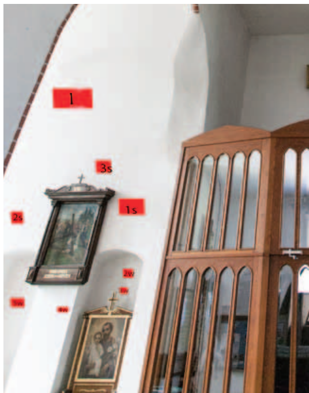
odkrywka SK-VI-L_4W- ściana południowa, glif 1 biała 2 szara 3 kremowa 4 tynk szary, wapienny z dodatkiem cementu 5 tynk jasnoróżowy 6 cegła
