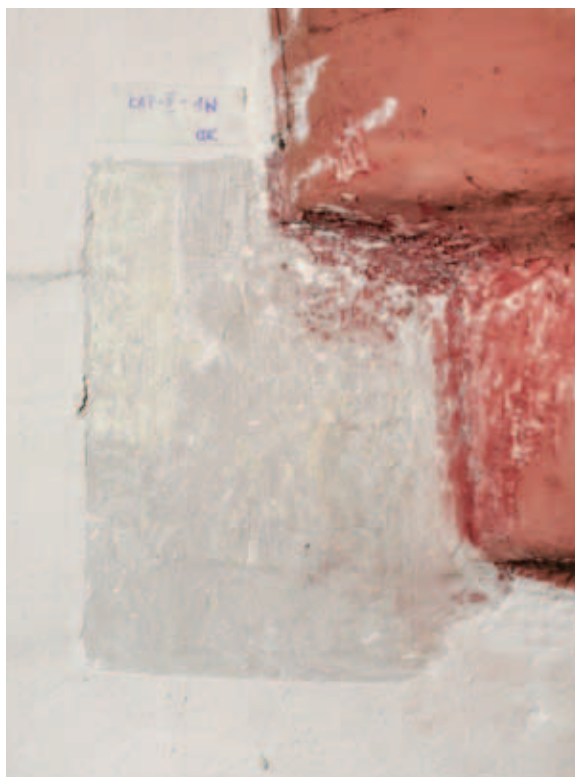
odkrywka KAP-II-P_1W- ściana południowa
