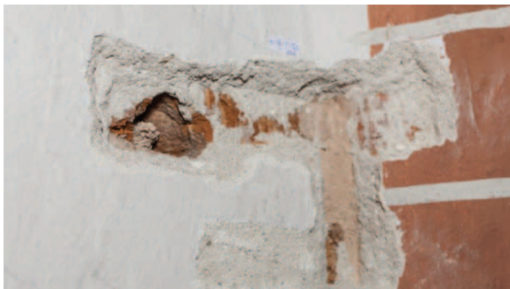
odkrywka N-III-P_2S- wysklepek i żebro
