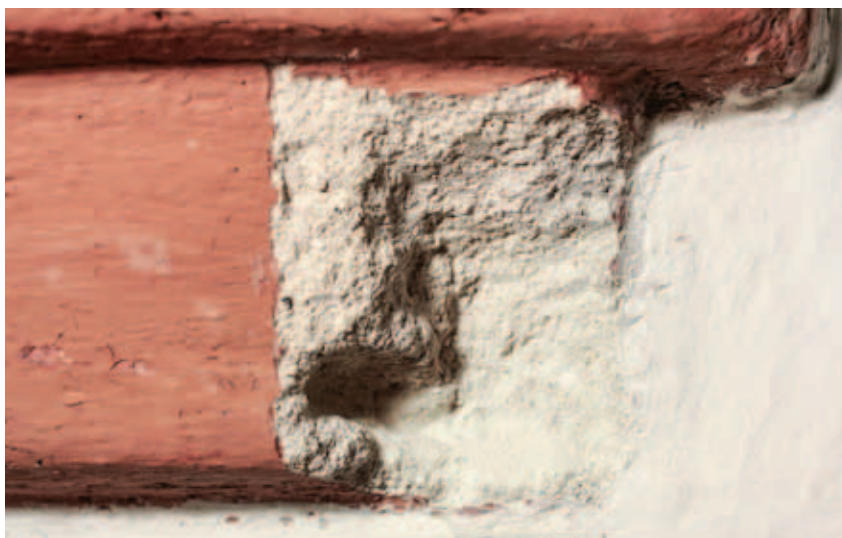
odkrywka KAP-III-L_3W- ściana północna 1 biała/czerwona 2 szarobłękitna 3 tynk szary, wapienny z dodatkiem cementu
