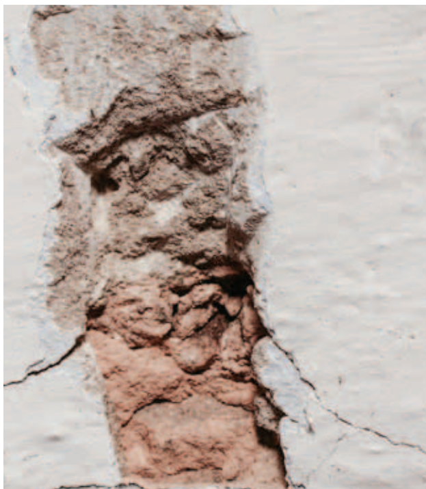
okrywka NG-III-L_8S- wysklepek 1 biała 2 biała 3 błękitna 4 kremowa 5 tynk szary, wapienny z dodatkiem cementu 6 tynk jasnoróżowy
