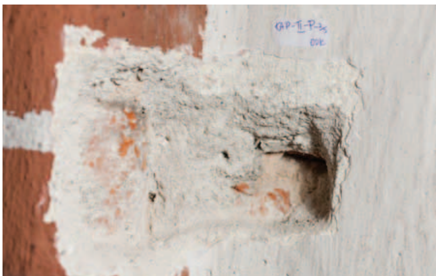
odkrywka KAP-II-P_3S- wysklepek i żebro 1 biała 2 szarobłękitna 3 kremowa 4 biała 5 tynk szary, wapienny z dodatkiem cementu 6 cegła
