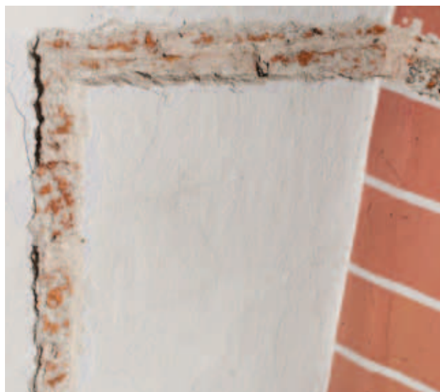
odkrywka NG-III-P_7S- wysklepek i żebro 1 biała 2 błękitna 3 tynk szary, wapienny z dodatkiem cementu 4 tynk jasnoróżowy 5 cegła
