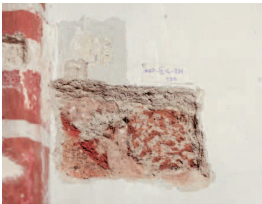
odkrywka KAP-III-L_2W- ściana północna 1 biała 2 szarobłękitna 3 kremowa 4 tynk szary, wapienny z dodatkiem cementu 5 tynk jasnoróżowy 6 cegła
