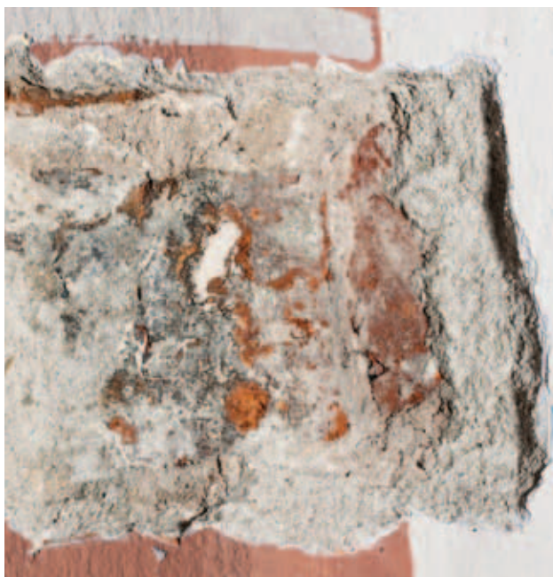
odkrywka NG-I-P_5S- żebro i wysklepek
