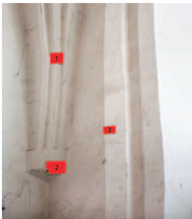
odkrywka CH-III-P_1W- żebro 1 biała 2 kremowa 2 tynk szary, wapienny z dodatkiem cementu 3 cegła
