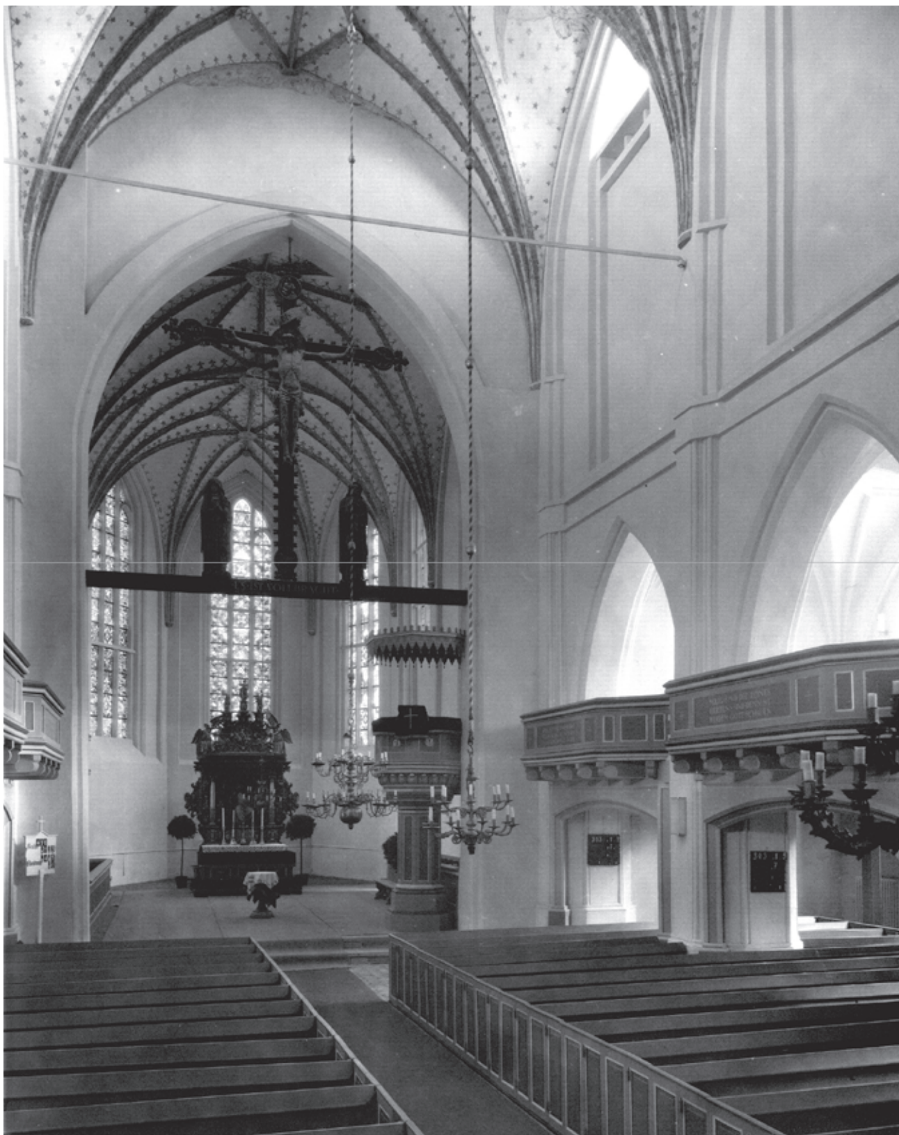
Kościół mariacki w Sławnie – wnętrze, zdjęcia archiwalne, widok na prezbiterium po remoncie przeprowadzonym w 1931 roku – widoczne opracowanie polichromii na sklepieniu na podstawie odkrytych XV wiecznych malowideł
