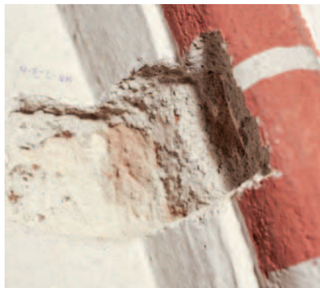
odkrywka N-II-L_2W- ściana północna 1 biała 2 szara 3 tynk szary, wapienny z dodatkiem cementu 4 tynk jasnoróżowy
