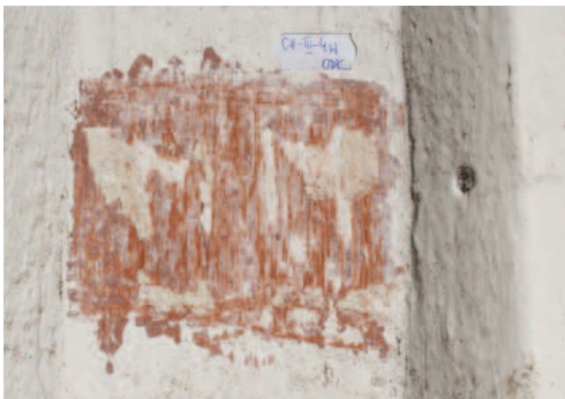
odkrywka CH-III-L_4W- ściana pół- nocna, glif 1 biała 2 czerwona 3 jasnoczerwona 4 kremowa
