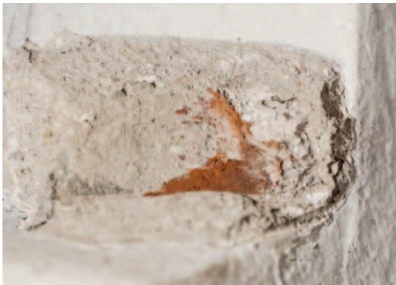
odkrywka CH-III-P_2W- konsola południowa
