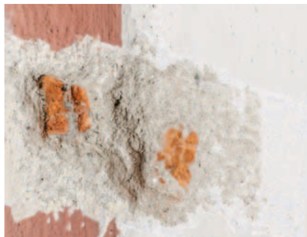
odkrywka NG-I-P_35- wysklepek i żebro 1 biała/czerwona 2 błękitna 3 kremowa 4 tynk szary, wapienny z dodatkiem cementu 5 cegła
