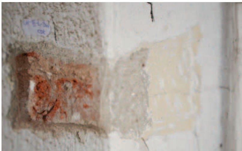
odkrywka CH-III-L_3W- ściana pół- nocna 1 biała 2 szarobłękitna 3 kremowa 4 tynk szary, wapienny z dodatkiem cementu 6 cegła
