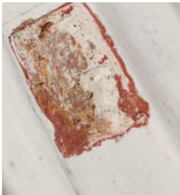
odkrywka P-III-P-7W- portal, ściana południowa
