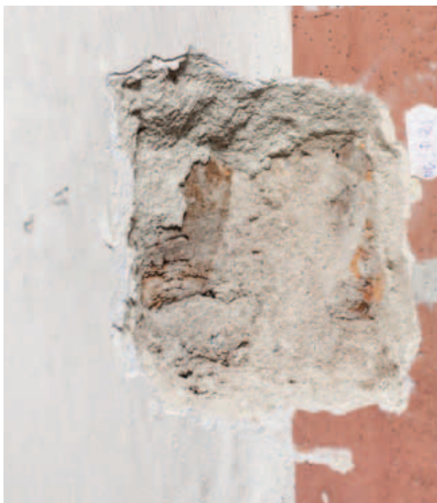
odkrywka NG-I-P_2S- wysklepek i żebro
