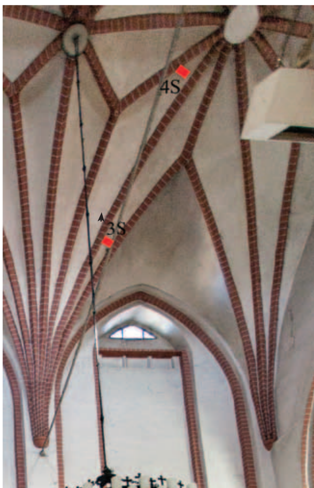
odkrywka NG-I-L_3S-wysklepek, spływ do konsoli 1 biała 2 błękitna 3 kremowa 4 tynk szary, wapienny z dodatkiem cementu
