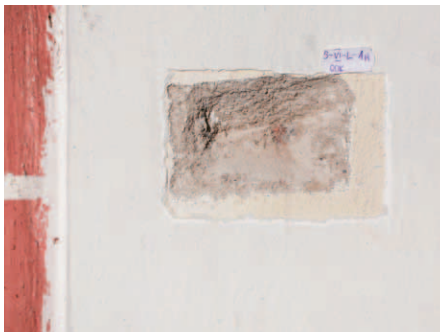
odkrywka S-VI-L_1W- ściana północna
