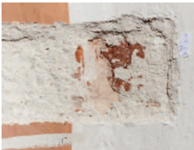
odkrywka NG-III-L_35- wysklepek i żebro 1 biała/czerwona 2 biała 3 tynk szary, wapienny z dodatkiem cementu 4 tynk jasnoróżowy 5 cegła
