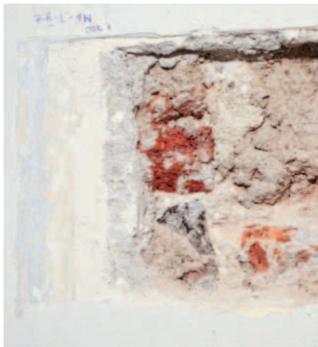
odkrywka P-III-L-1W- ściana północna, nisza
