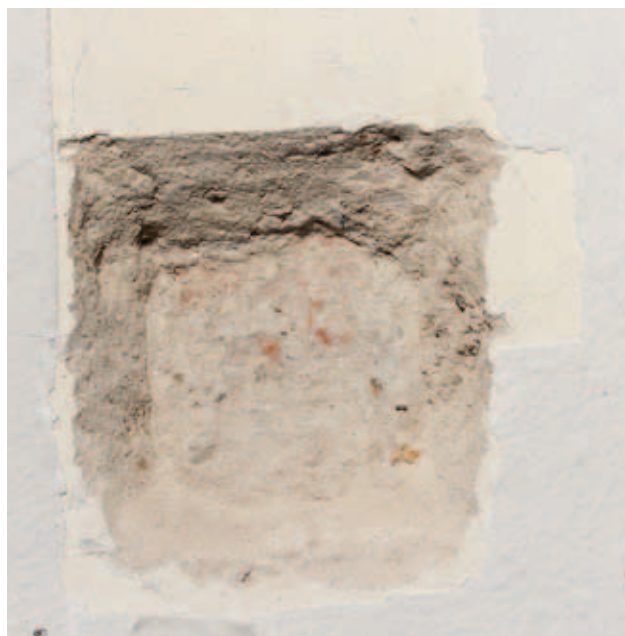
odkrywka N-I-L_7S- wysklepek 1 biała 2 kremowa 3 tynk szary, wapienny z dodatkiem cementu
