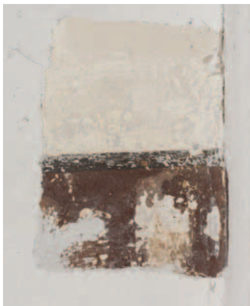
odkrywka KAP-IV-ZACH_4W- ściana zachodnia
