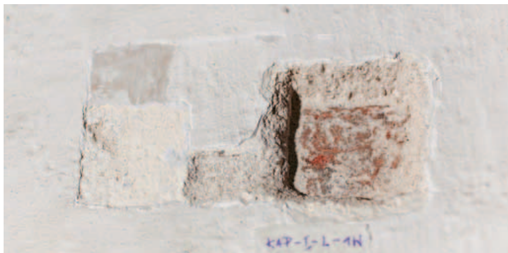
odkrywka KAP-I-L_1W- ściana północna
