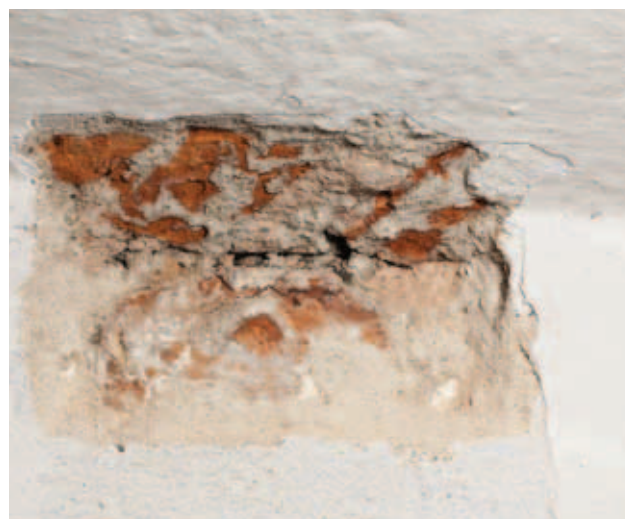
odkrywka NG-I-P_8W- gładz okiennej
