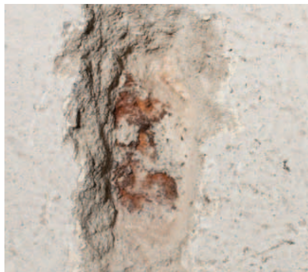
odkrywka NG-III-P_1W- ściana południowa 1 biała 2 kremowa 4 tynk szary, wapienny z dodatkiem cementu 5 zabrudzenie 6 tynk jasnoróżowy 7 cegła
