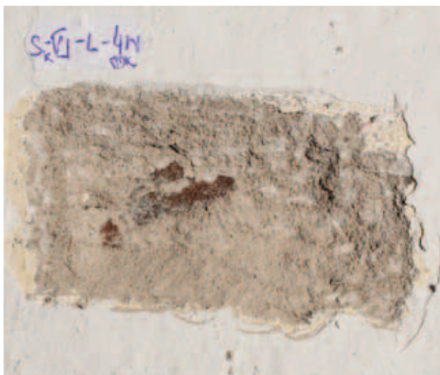
odkrywka SK-VI-L_4W- ściana południowa, glif 1 biała 2 szara 3 kremowa 4 tynk szary, wapienny z dodatkiem cementu 5 tynk jasnoróżowy 6 cegła
