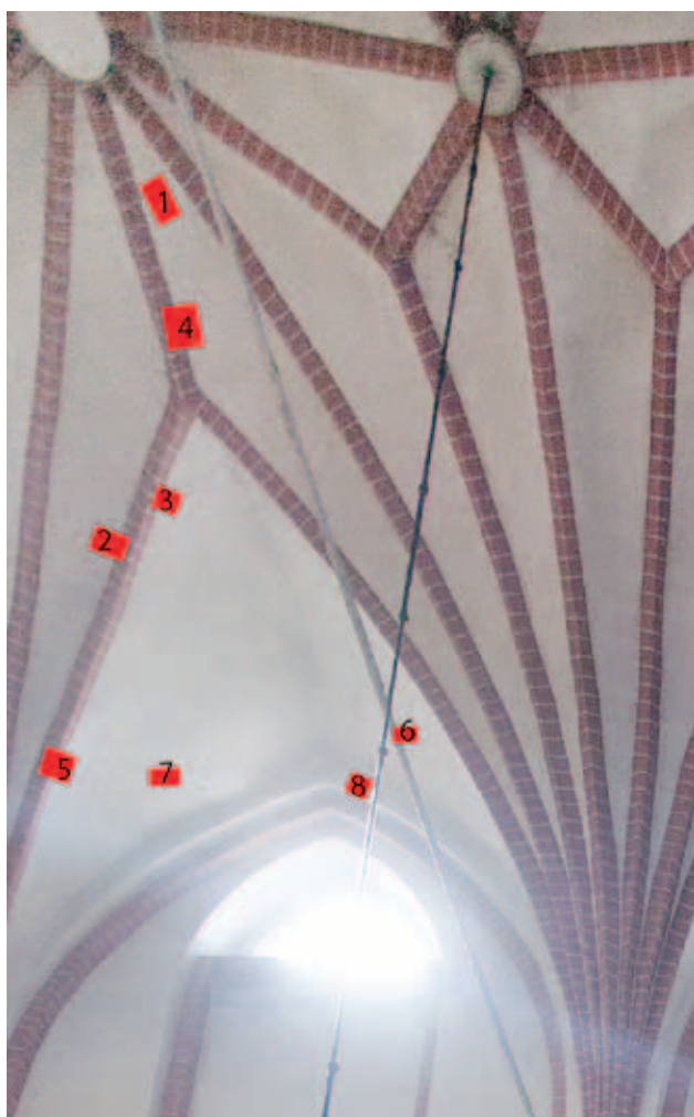
odkrywka NG-I-P_45- wysklepek i żebro 1 biała 2 błękitna 3 kremowa 4 tynk szary, wapienny z dodatkiem cementu 5 tynk jasnoróżowy 6 cegła
