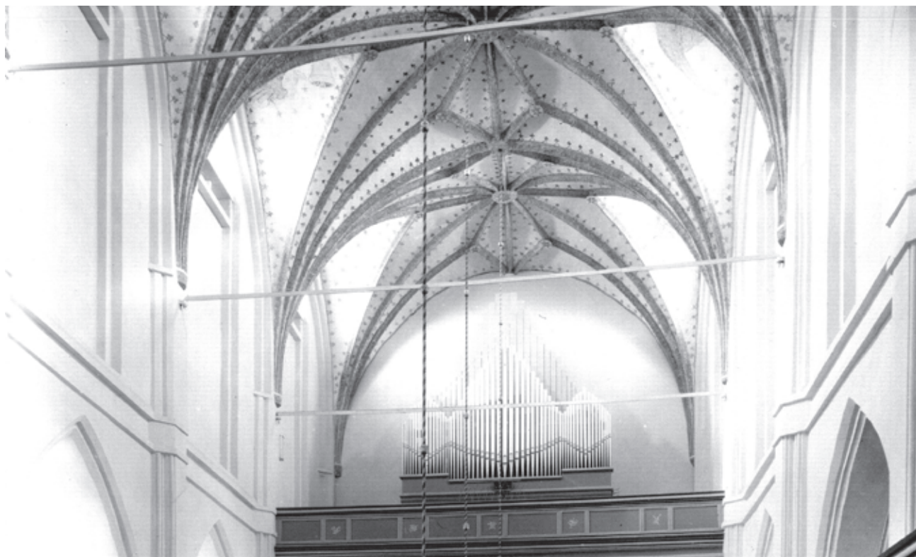
Zdjęcie archiwalne – sklepienie nawy głównej (nad chórem) po remoncie przeprowadzonym w 1931 roku –widoczne odsłonięte XV wieczne polichromie, ornament roślinny wzdłuż żeber
