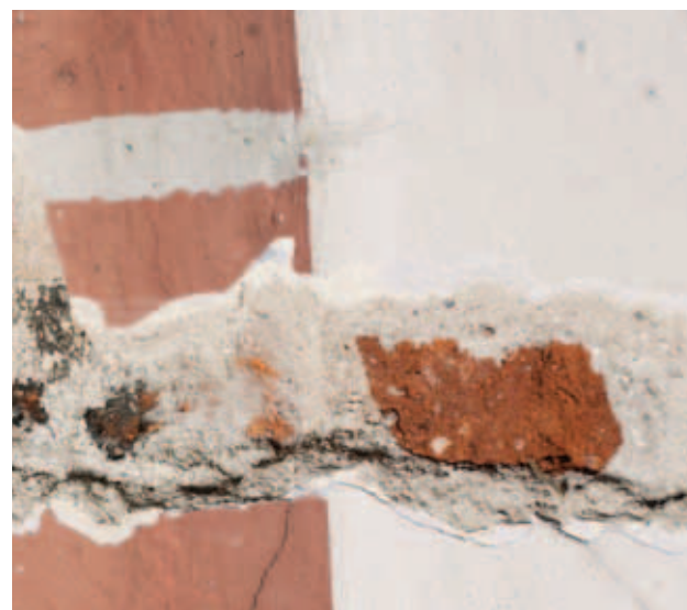
odkrywka NG-II-P_4S- żebro sklepienne
