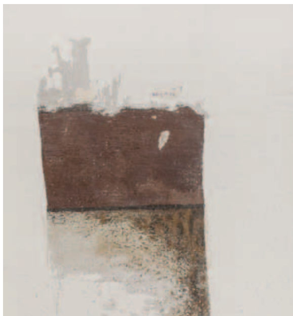
odkrywka KAP-II-P_2W- ściana południowa 1 biała 2 błękitna 3 brązowa 4 kremowa 5 brązowa
