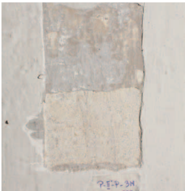
odkrywka P-II-P-3W- ściana południowa
