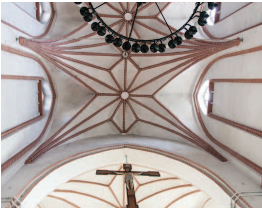
Zdjęcie z roku 2012 obecny wygląd sklepienia nawy głównej
