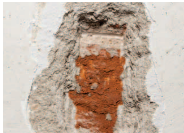
odkrywka NG-II-P_3S- wysklepek
