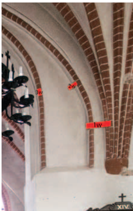
odkrywka N-II-L_2W- ściana północna 1 biała 2 szara 3 tynk szary, wapienny z dodatkiem cementu 4 tynk jasnoróżowy
