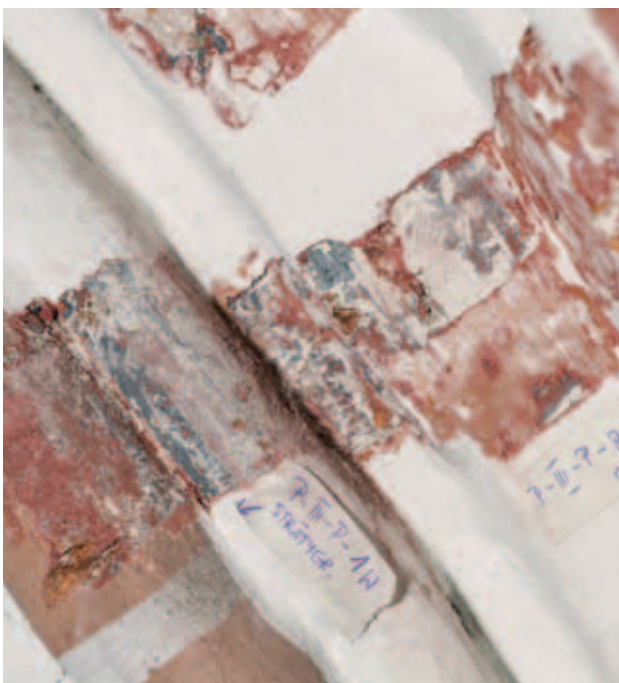
odkrywka P-III-P-8W- uskok w portalu
