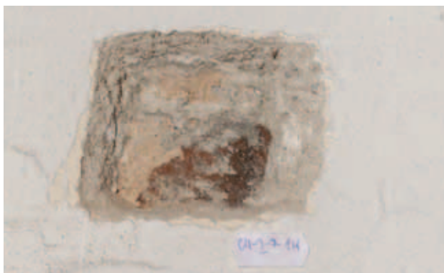
odkrywka CH-I-P_1W- ściana południowa
