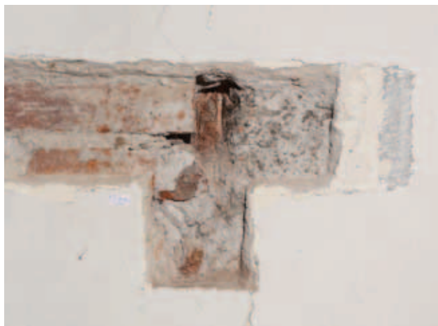
odkrywka N-I-WSCH_1- ściana płn.-wsch.
