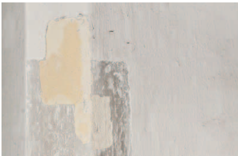
odkrywka KAP-IV-ZACH_6W- ściana północna
