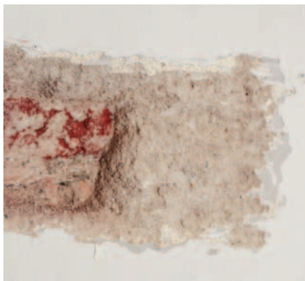
odkrywka NK-VI-L_4W- ściana pn.-zach., nisza 1 biała 2 szara 3 szara 4 tynk szary, wapienny z dodatkiem cementu 5 tynk jasnoróżowy 8 cegła
