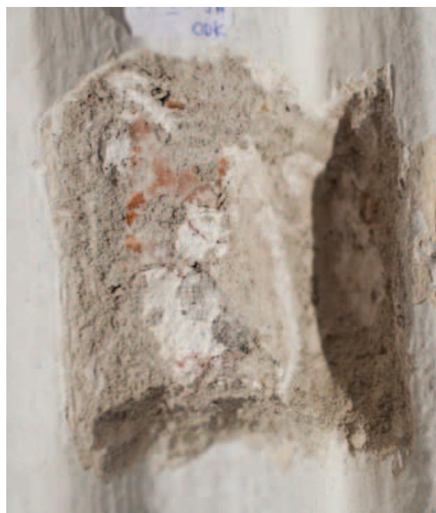
odkrywka CH-III-P_1W- żebro 1 biała 2 kremowa 2 tynk szary, wapienny z dodatkiem cementu 3 cegła
