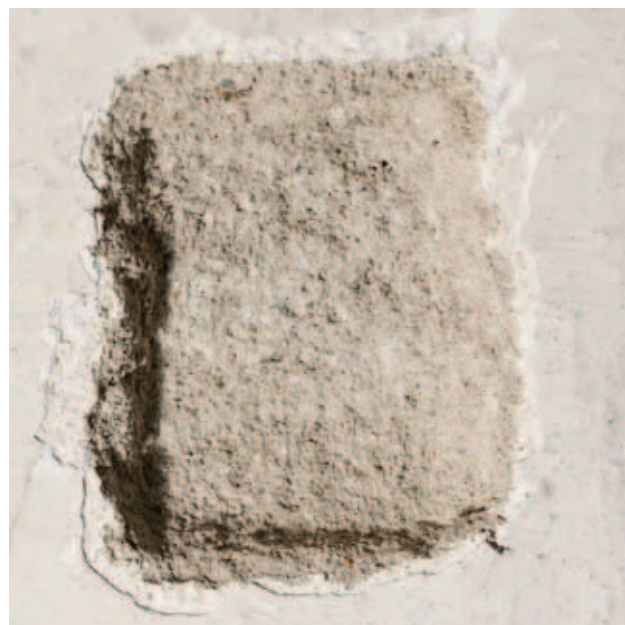
odkrywka NG-IV-L_75- wysklepek 1 biała 2 błękitna 3 kremowa 4 tynk szary, wapienny z dodatkiem cementu
