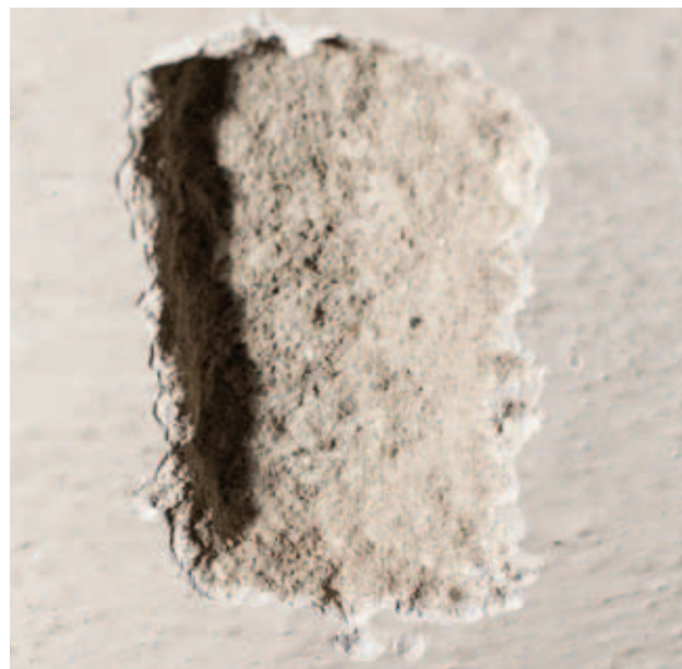
odkrywka NG-IV-L_85- wysklepek 1 biała 2 błękitna 3 kremowa 4 tynk szary, wapienny z dodatkiem cementu
