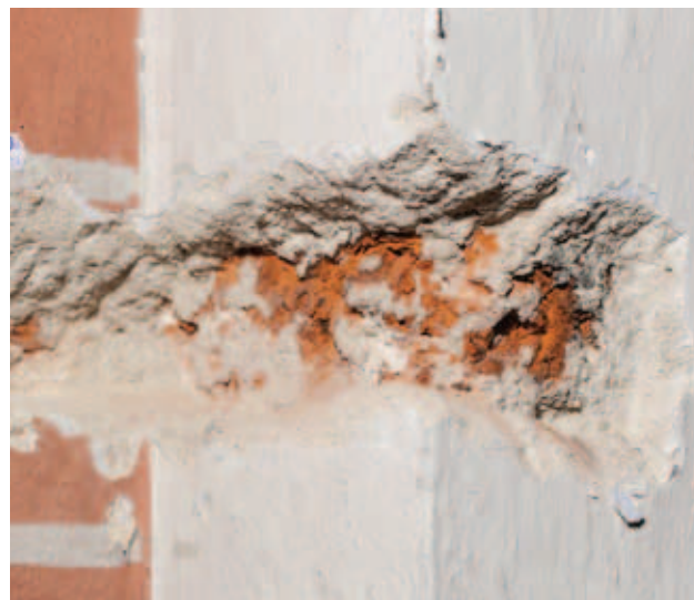
odkrywka NG-III-P_10W- glif okienny, ściana pld. 1 biała 2 błękitna 4 tynk szary, wapienny z dodatkiem cementu 5 cegła
