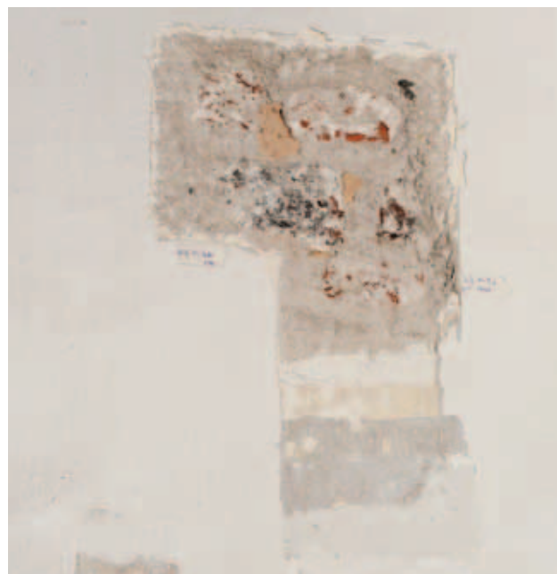
odkrywka P-II-P-4W- ściana południowa
