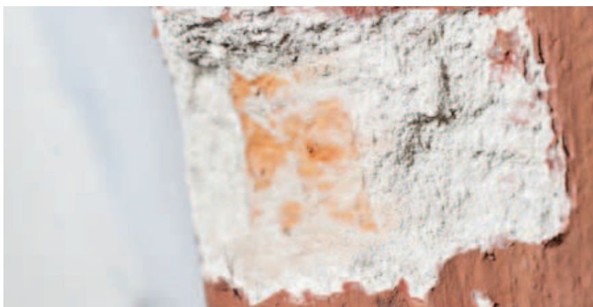
odkrywka KAP-II-P_4S – żebro sklepienne 1 czerwona 2 szarobłękitna 3 tynk szary, wapienny z dodatkiem cementu 4 cegła
