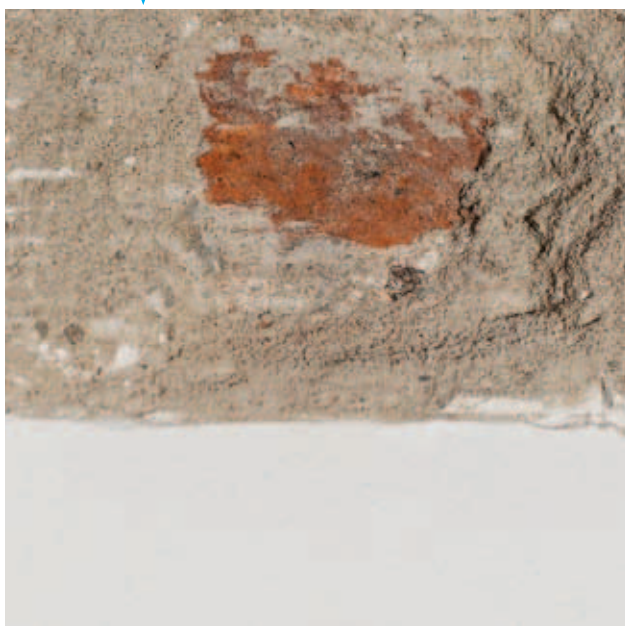
odkrywka K-W_1W- ściana zachodnia
