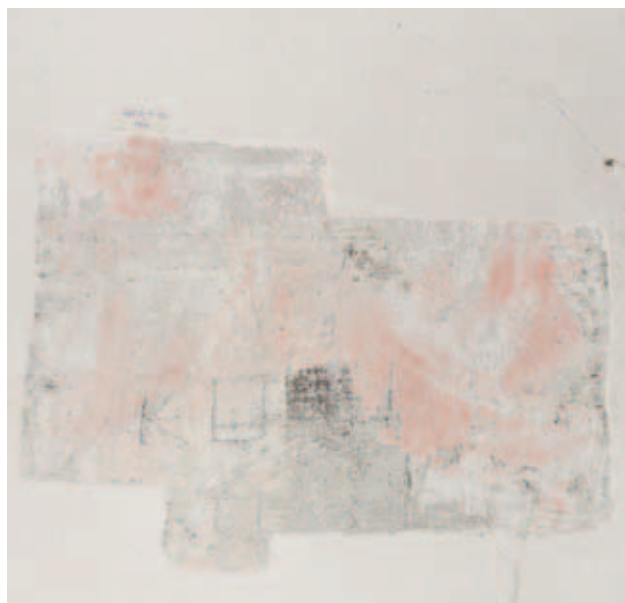
odkrywka KAP-III-P_4W – ściana południowa 1 biała 2 biała 2 szarobłękitna 3 różowa/ biała 4 brązowa
