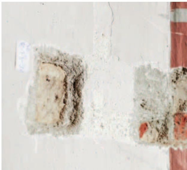
odkrywka NG-II-L_2S- wysklepek i żebro
