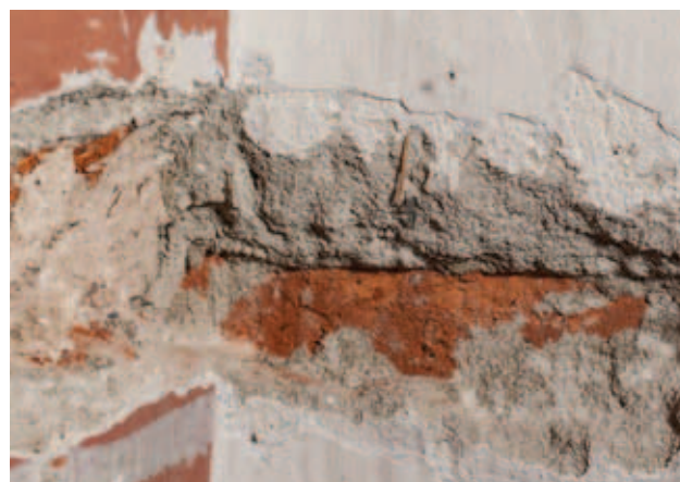
odkrywka NG-IV-P_25- wysklepek i żebro
