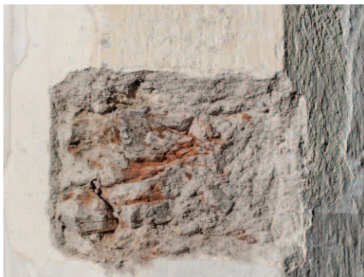
odkrywka KAP-IV-ZACH_3W- ściana zachodnia
