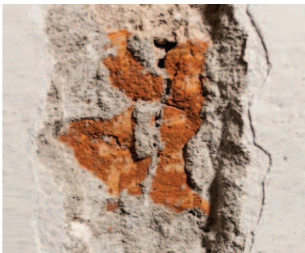
odkrywka NG-IV-L_5S- wysklepek
