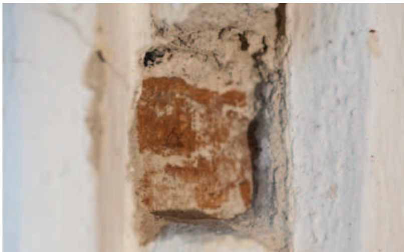
odkrywka CH-III-L_1W- spływ żeber 1 biała 2 kremowa 3 tynk szary, wapienny z dodatkiem cementu 4 tynk jasnoróżowy 5 cegła
