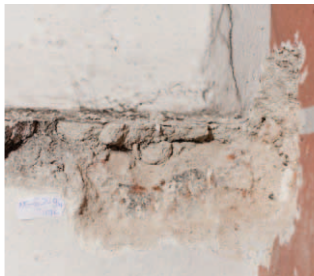
odkrywka NG-III-P_9W- ściana południowa 1 biała 2 błękitna 3 kremowa 4 tynk szary, wapienny z dodatkiem cementu 5 zabrudzenie 6 cegła
