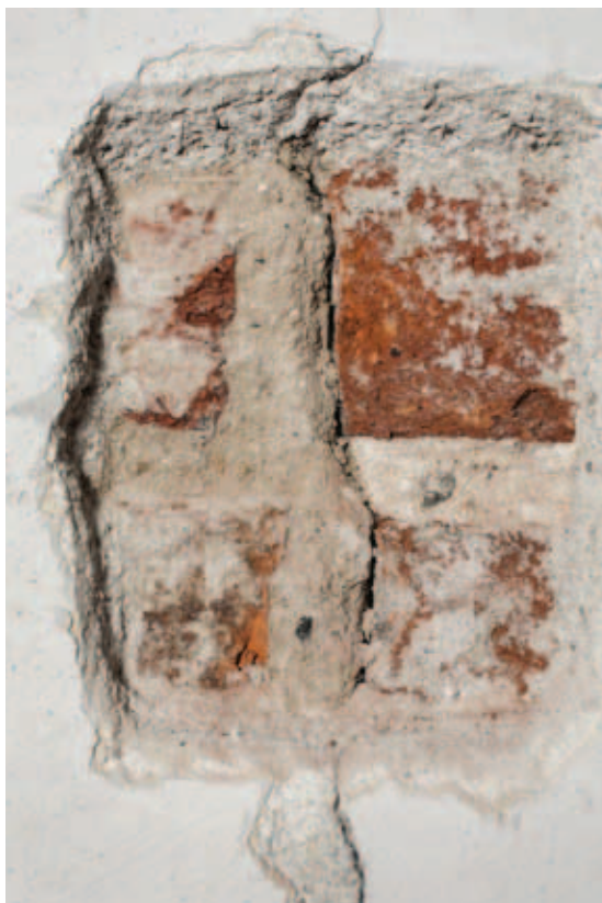
odkrywka KAP-IV-L_1W- ściana północna 1 biała 2 szarobłękitna 3 kremowa 4 tynk szary, wapienny z dodatkiem cementu 5 tynk jasnoróżowy 6 cegła
