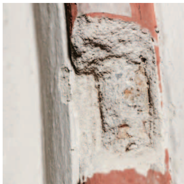
odkrywka N-II-L_3W- ściana północna, opaska 1 czerwona 2 biała 3 tynk szary, wapienny z dodatkiem cementu 4 cegła
