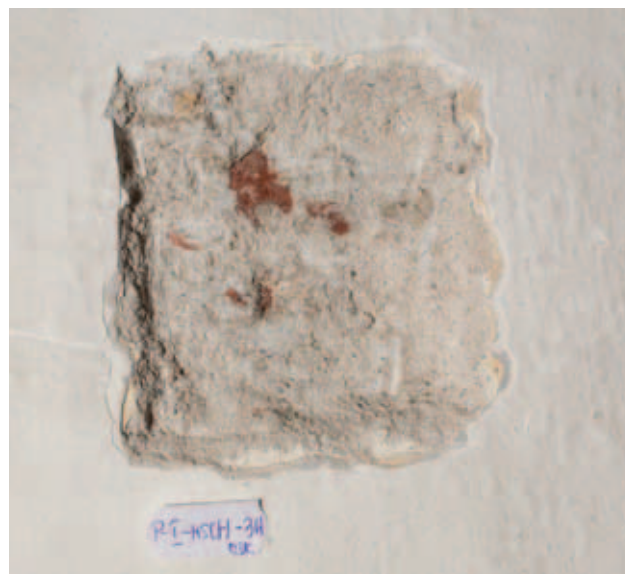
odkrywka P-I-WSCH_3W- ściana wschodnia 1 biała 2 szara 3 kremowa 4 tynk szary, wapienny z dodatkiem cementu 5 cegła
