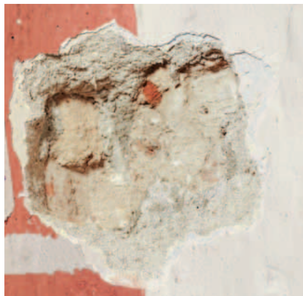
odkrywka NG-III-L_6S- wysklepek i żebro 1 czerwona 2 biała 3 błękitna 4 kremowa 5 tynk szary, wapienny z dodatkiem cementu 6 cegła
