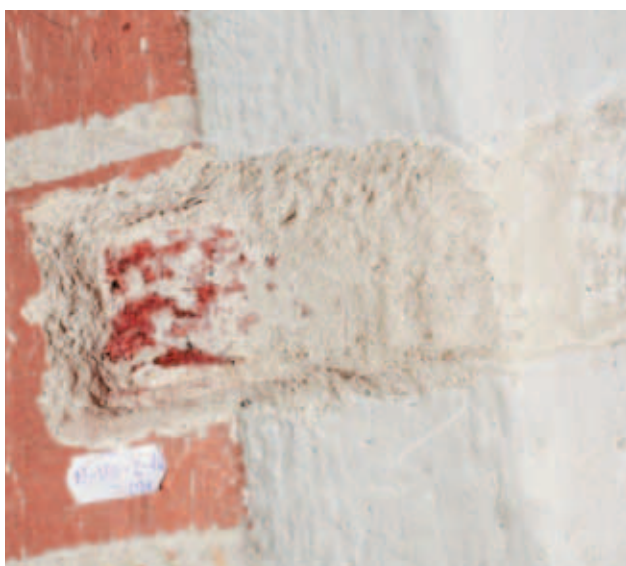
odkrywka N-VII-L_1W- ściana północna 1 czerwona 2 biała 3 szara 4 kremowa 5 tynk szary, wapienny z dodatkiem cementu 6 tynk jasnoróżowy 7 cegła
