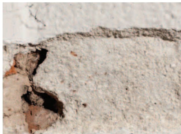
odkrywka N-I-L_9S- wysklepek
